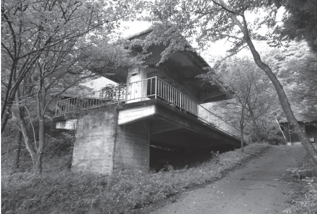
写真1 妙義リフト乗り場の跡
