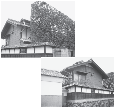
写真1 桎ぐねを持つ越屋根付き養蚕農家建物
