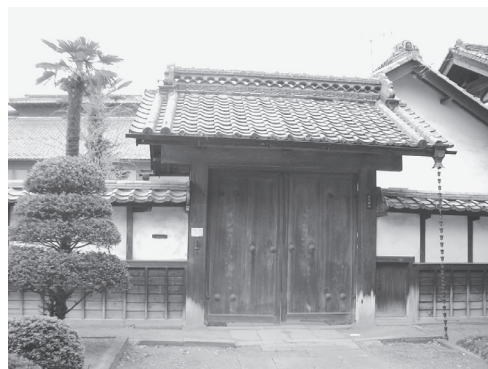
写真2 門構えの大型養蚕農家建物
