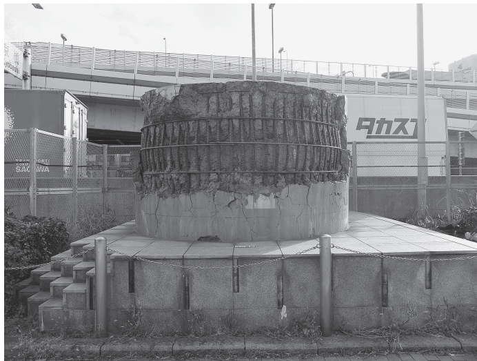
図4 阪神淡路大震災により被害を受けた阪神高速道路の橋脚の遺構 神戸市中央区新港町 2011年12月 筆者撮影
