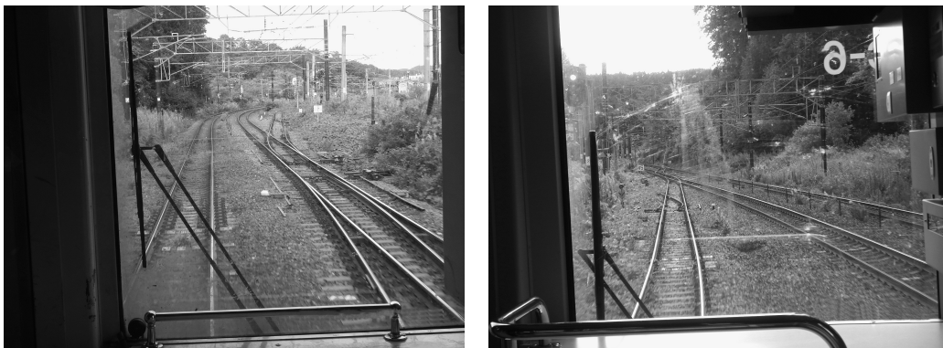
写真5 東北本線と仙石線を繋ぐ仙石東北ラインの渡り線 (左は東北本線側・右は仙石線側から見たもので、渡り線には架線が張られていない) (2021年9月16日筆者撮影)
