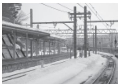
写真26 水上駅構内（みなかみ町） 水上駅の標高は491.5m（新潟駅から169.8km）。
