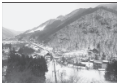
写真21 上越線 湯檜曽ループ（みなかみ 町） ちょうど真下にこれから通る線 路がみえる。
