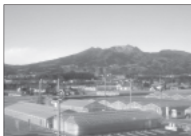
写真32 上越線 敷島～渋川間（渋川市） 敷島駅の標高は233.9m（新潟駅から201.4km）。渋川駅の標高は181.0m（新潟駅から207.8km）。
