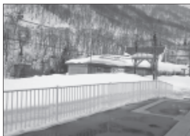
写真20 土合駅構内（みなかみ町） 土合駅（上り線）の標高は 655.5m（新潟駅から159.6km）。 なお、同駅（下り線）の標高は 583.4m。
