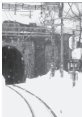
写真19 上越線 清水トンネルの土合駅側 (みなかみ町)
